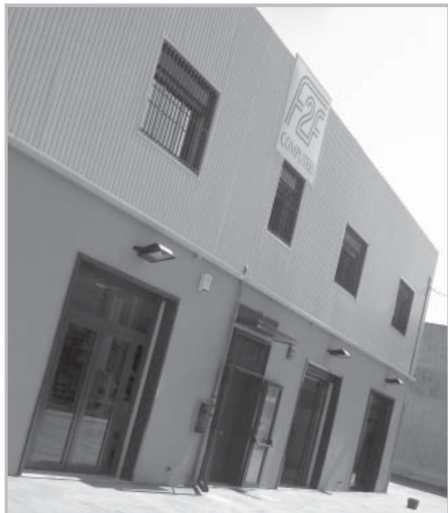
Una veduta dall'esterno della nuova sede di F2F Computers
